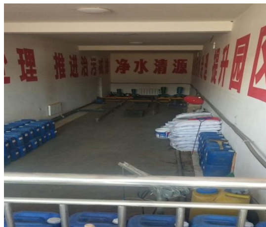
清水川工业园区生活污水处理站
