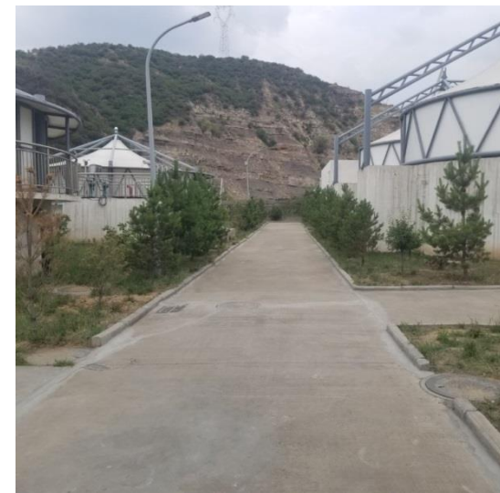
新民镇生活污水处理厂
