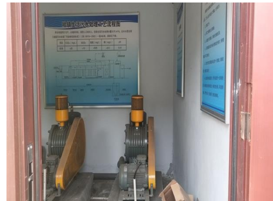
哈镇污水处理站
